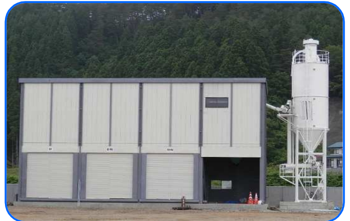
■バッチャープラント
