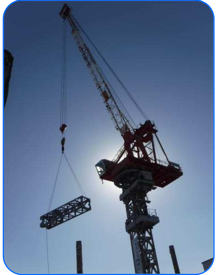
■タワークレーン
